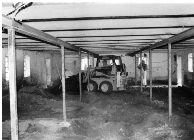
1984 – stalden under indretning til udstilling.
