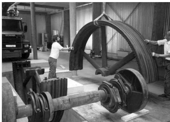
1989 – Montering af dampmaskinen i Hallen.
