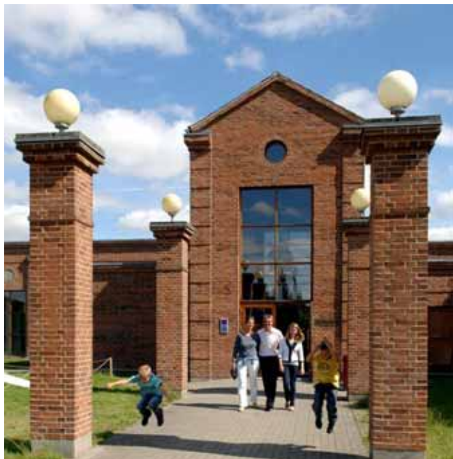
Elmhøjhuset hovedbygning fra 1994.
