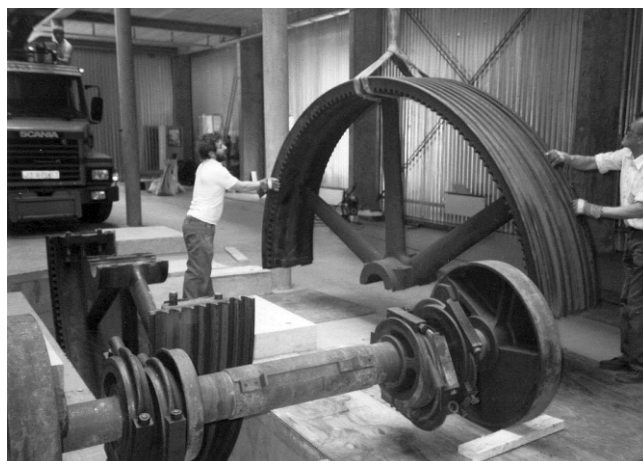
1989 – Montering af dampmaskinen i Hallen.
