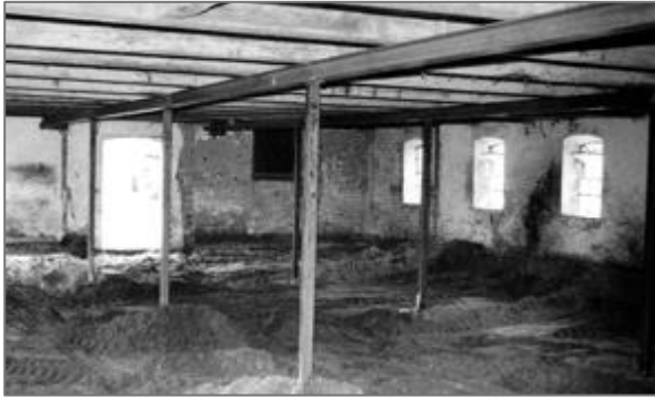
Gudenaacentralens ladebygning, som blev omdannet til udstillingsområde for museet. I dag indeholder bygningen udstillingen VIND.
